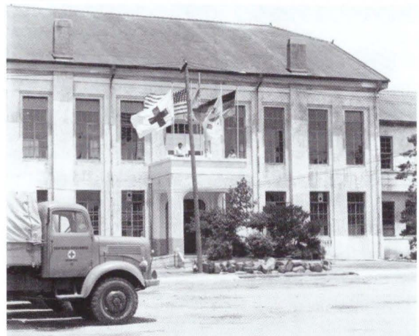
Eingangsbäude des „Deutsches Rotes Kreuz-Hospital“ vor der Instandsetzung, Pusan 1954
