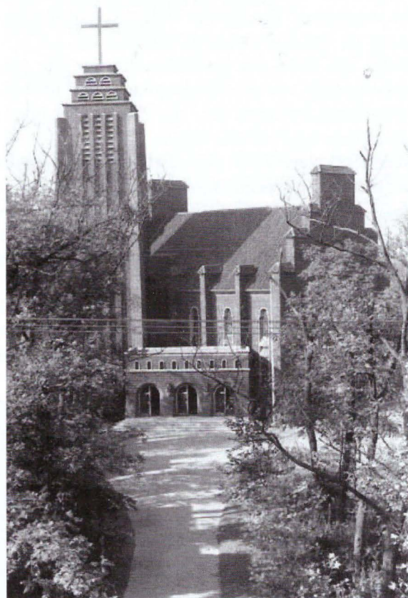
Deutsche Evangelische Kirche Shanghai, Architekt L. Hudek, errichtet 1932 Quelle: StuDeO-Fotothek P4735
