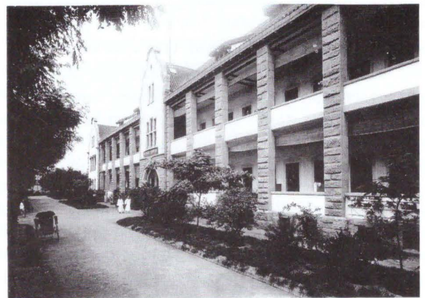
Deutsches Hospital Peking, um 1930 Ende der 30er Jahre wurde das Gebäude um ein Stockwerk erhöht.
