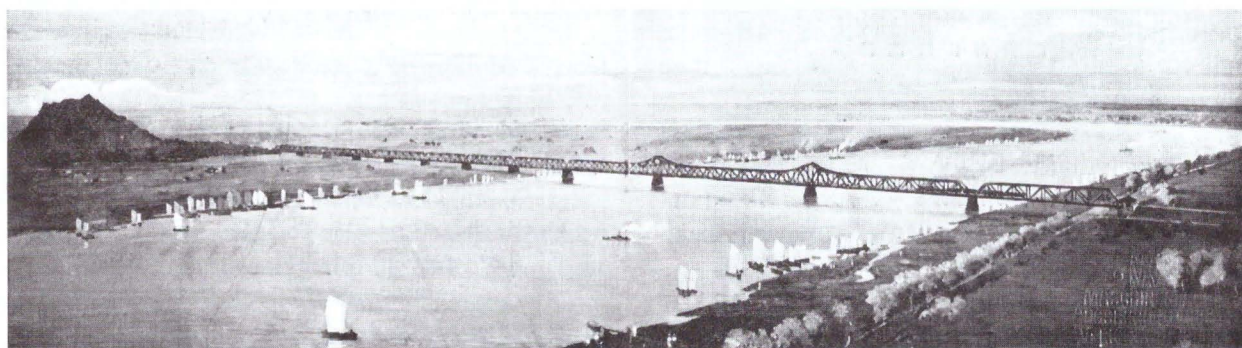
Hoangho-Brücke der Tientsin-Pukow-Bahn, 1912
