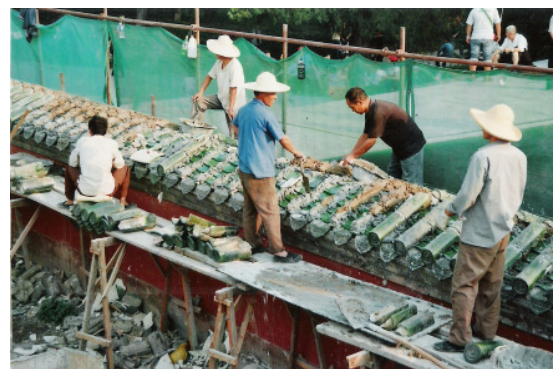
Renovierungsarbeiten im Gelände des Himmelstempels
