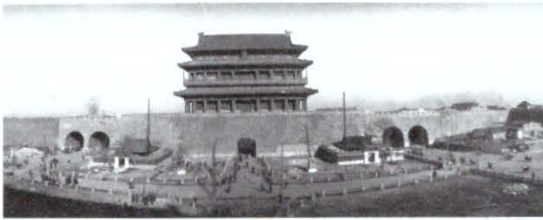
Blick vom Wehrturm nach Norden, 1916 Die Totale veranschaulicht die baulichen Maßnahmen in der Stadtmauer. Die vier neuen großen Tunnel rechts und links des Turmaufbaus erlauben nun auch ungehinderten Auto- und Straßenbahnverkehr zwischen der Tartaren- und der Chinesenstadt. Bildquelle: The Old City Gates of Beijing , S. 27. Beijing Arts and Photography Publ. House (2001)
