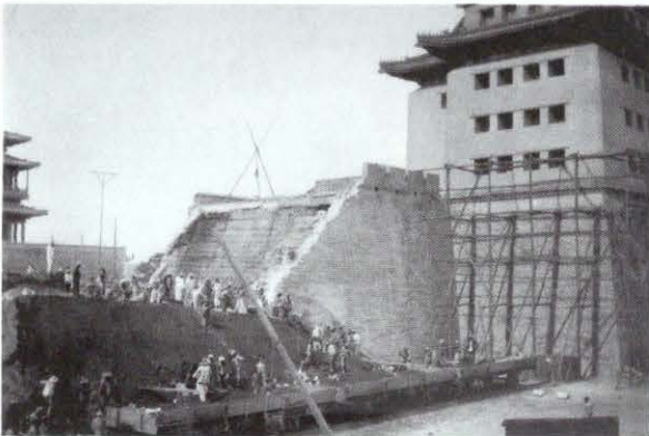
2. Juli 1915: Auf der Westseite des Wehrturms Die aus Steinquadern errichteten und mit Lehm aufgefüllten Mauern werden abgetragen und die Trümmer sowie der Lehm mit der Eisenbahn abtransportiert.
