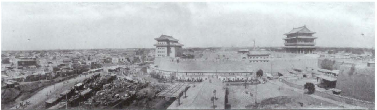
Das Stadttor Chien Men vor dem Umbau (Blick von Ost nach West)
