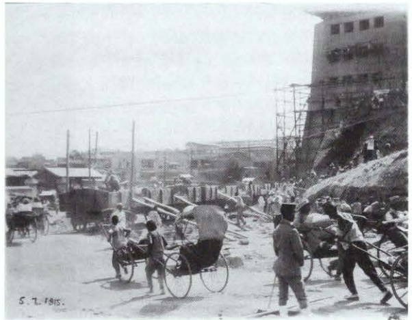
5. Juli 1915: An der Ostseite des Wehrturms wird die Rundmauer weiter abgetragen und in der Höhe an den Gesimsbändern gearbeitet. Der Verkehr läuft weiter, ein Polizist steht Wache.
